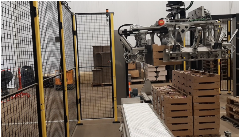
Ligne automatisée : palettisation
